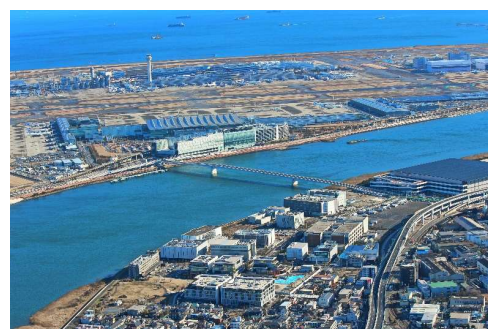
多摩川スカイブリッジ
